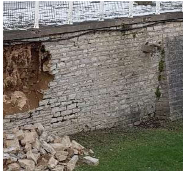
Vue sur mur en place mais présentant d'importantes pathologies au niveau des maçonneries.
