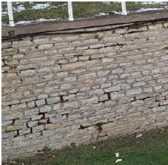
Vue sur mur en place mais présentant d'importantes pathologies au niveau des maçonneries.
